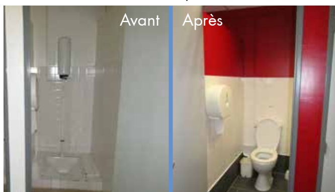
Les toilettes du Centre Culturel ont été rénovées.
