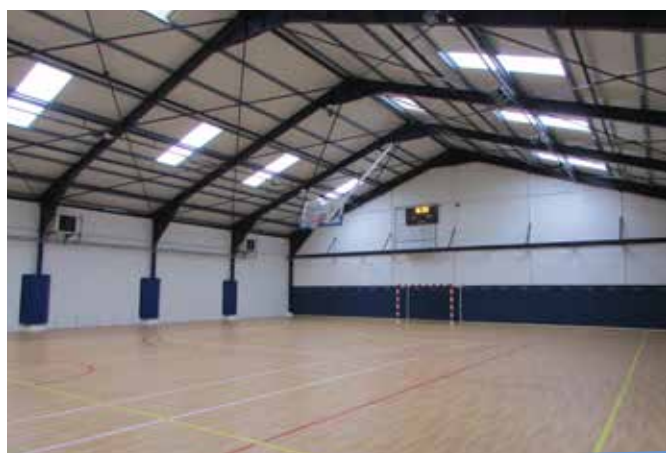
La première tranche des travaux est terminée.
