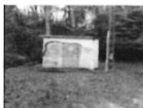
LARIVIERETTE Mise en service 1960 pompes 2 x 17 m 3 h
