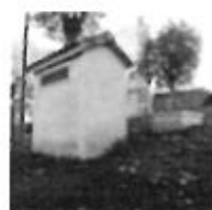
MONSEMPRON Mise en service 1953 Capacité 200 m 3 pompes 2 x 30 m 3
