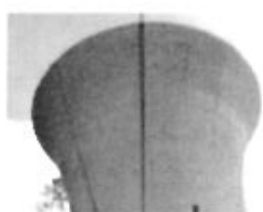
TRELAN Mise en service 1973 Capacité 600 m 3 pompes 2 x 30 m 3 h
