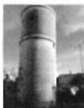
CONDEZAYGUES Mise en service 1957 Capacité 200 m 3
