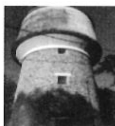
LOUBEJAC Mise en service 1956 Capacité 200 m 3 Pompes 3 x 1,7 m 3 h
