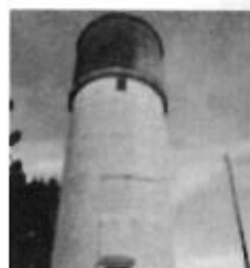
BOS LAROQUE Mise en service 1960 Capacité 100 m 3
