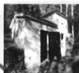
CALFOUR Mise en service 1958 Capacité 20 m 3 pompes 2 x 9,5 m 3 h
