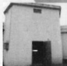
GUITOT Mise en service 1960 Capacité 1000 m 3 Pompes 2 x 50 m 3 h
